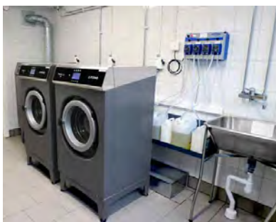
Pump-o-tronic kan styra upp till 4 pumpar för automatisk dosering av olika tvättmedel och sköljmedel.
